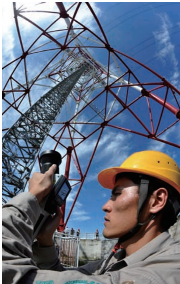
福建省莆田市で500キロボルトの送電線を検査する福建省第二電力建設会社の社員 (張国俊撮影)
