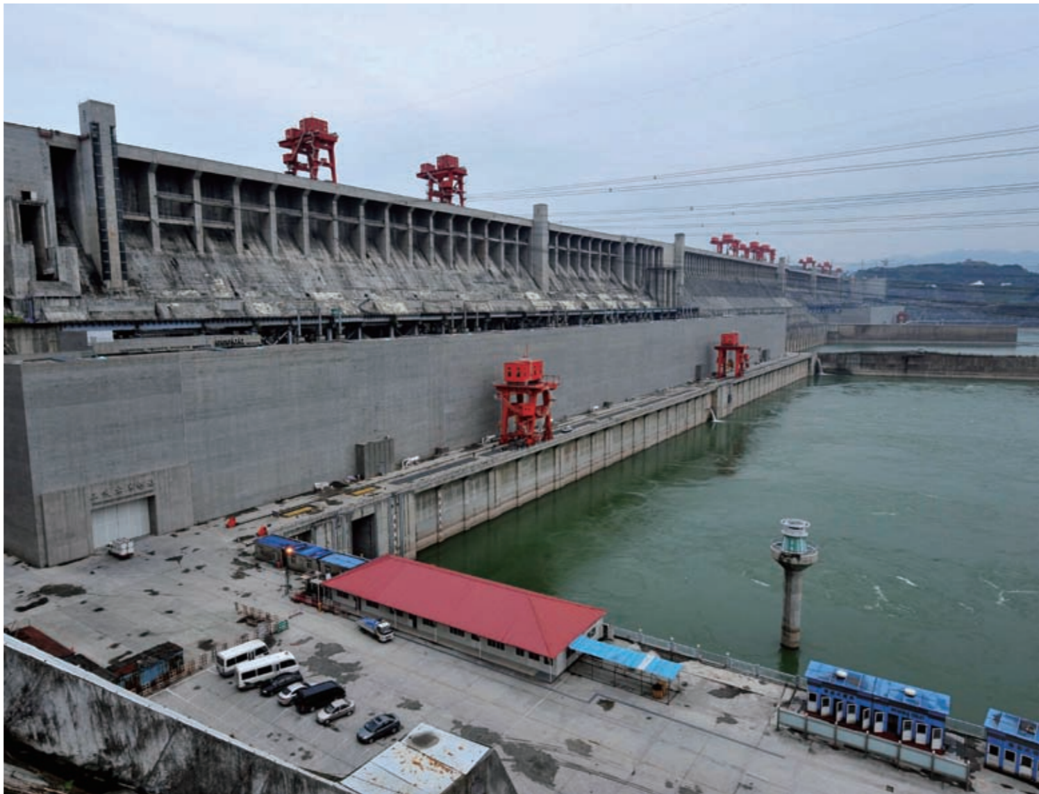
中国の水利建設は経済社会の発展についていけない。写真は三峡ダム（杜華挙撮影）
