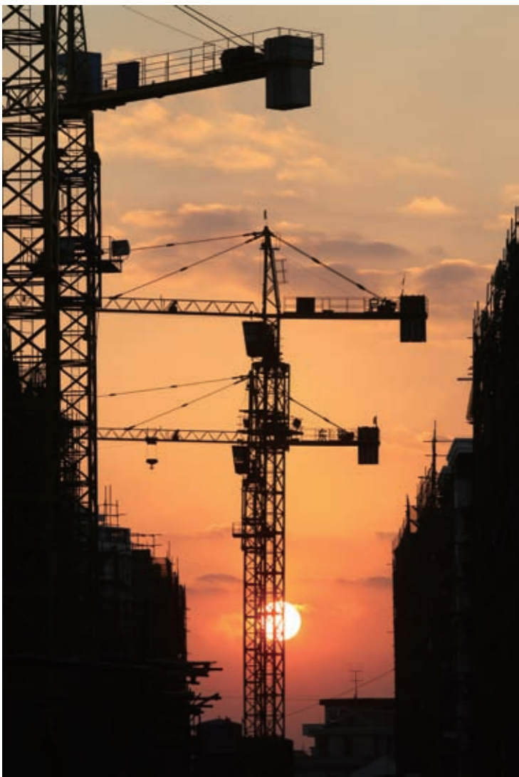
江蘇省南通市の商品住宅建設現場 (許叢軍撮影)
