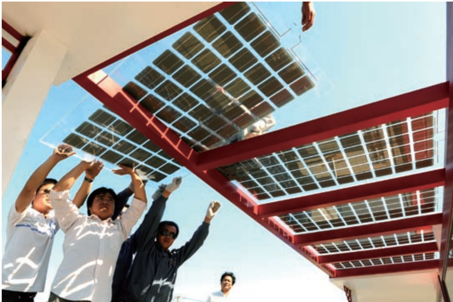
江蘇省連雲港市花果山大道脇に設置中の太陽光発電システム搭載バス停に、単結晶シリコン太陽電池を取り付ける作業員（耿玉和撮影）
