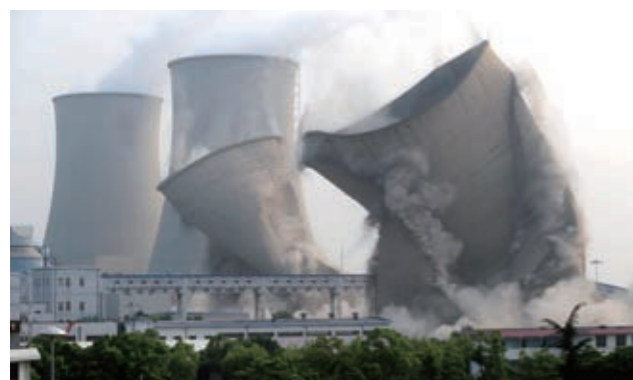
9月16日、浙江省長興県にある華能国際電力股份有限公司長興発電所で、政府の省エネ・CO2排出量削減作業計画に基づいて、高さ90メートルの巨大冷却塔2基が爆破解体された (徐昱撮影)
