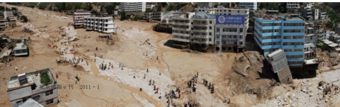
空から見た舟曲の土石流被災現場（8月8日撮影）（新華社）
