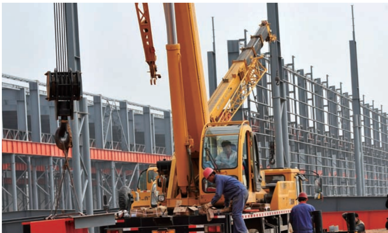
建設中の寧夏百万トンレアアースカラー鋼板プロジェクト
