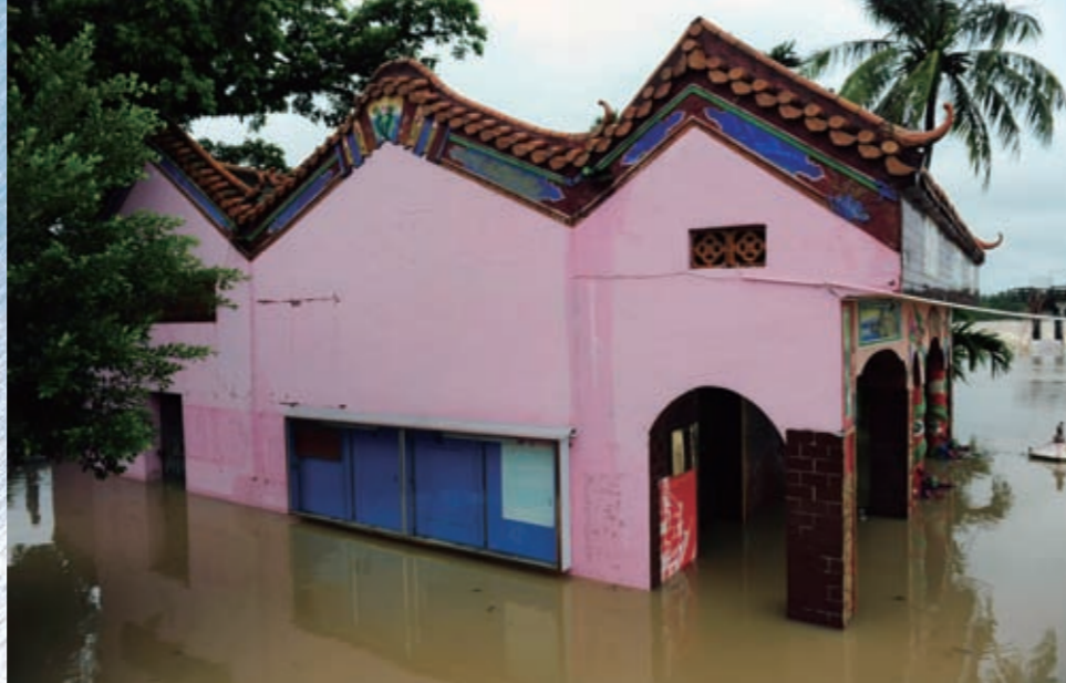
16日、海南省瓊海市万泉河岸の建物が豪雨で水浸しになった
