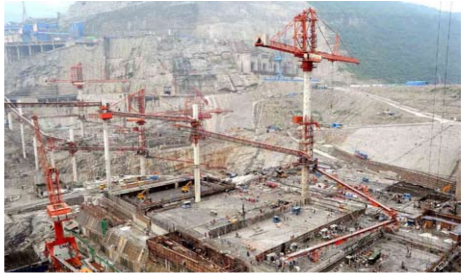
建設中の四川省宜賓の向家壩水力発電所。完成後は中国で3番目の大型水力発電所となる
