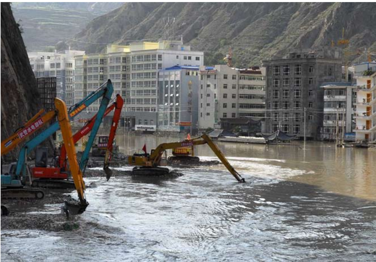
甘肅省舟曲県の土石流被災地で大型の掘削機を使って堰止め湖の水の排出を試みる武装警察水電部隊
